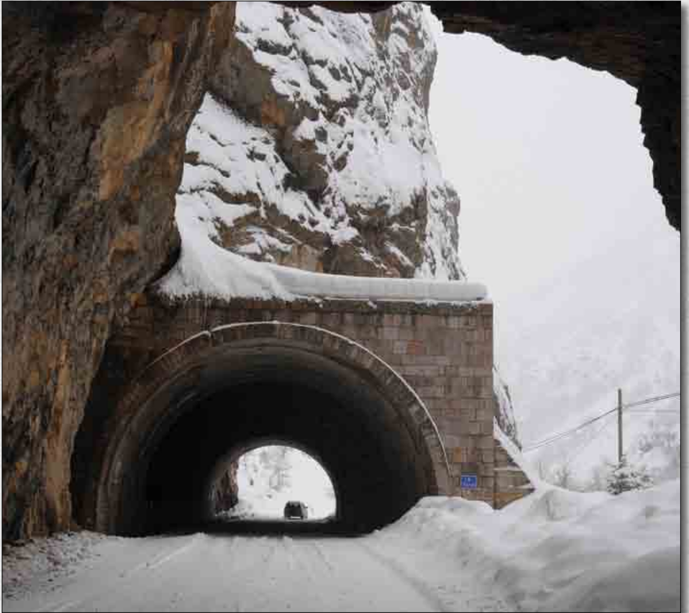
Pülümür Yolu Çığ Tüneli
