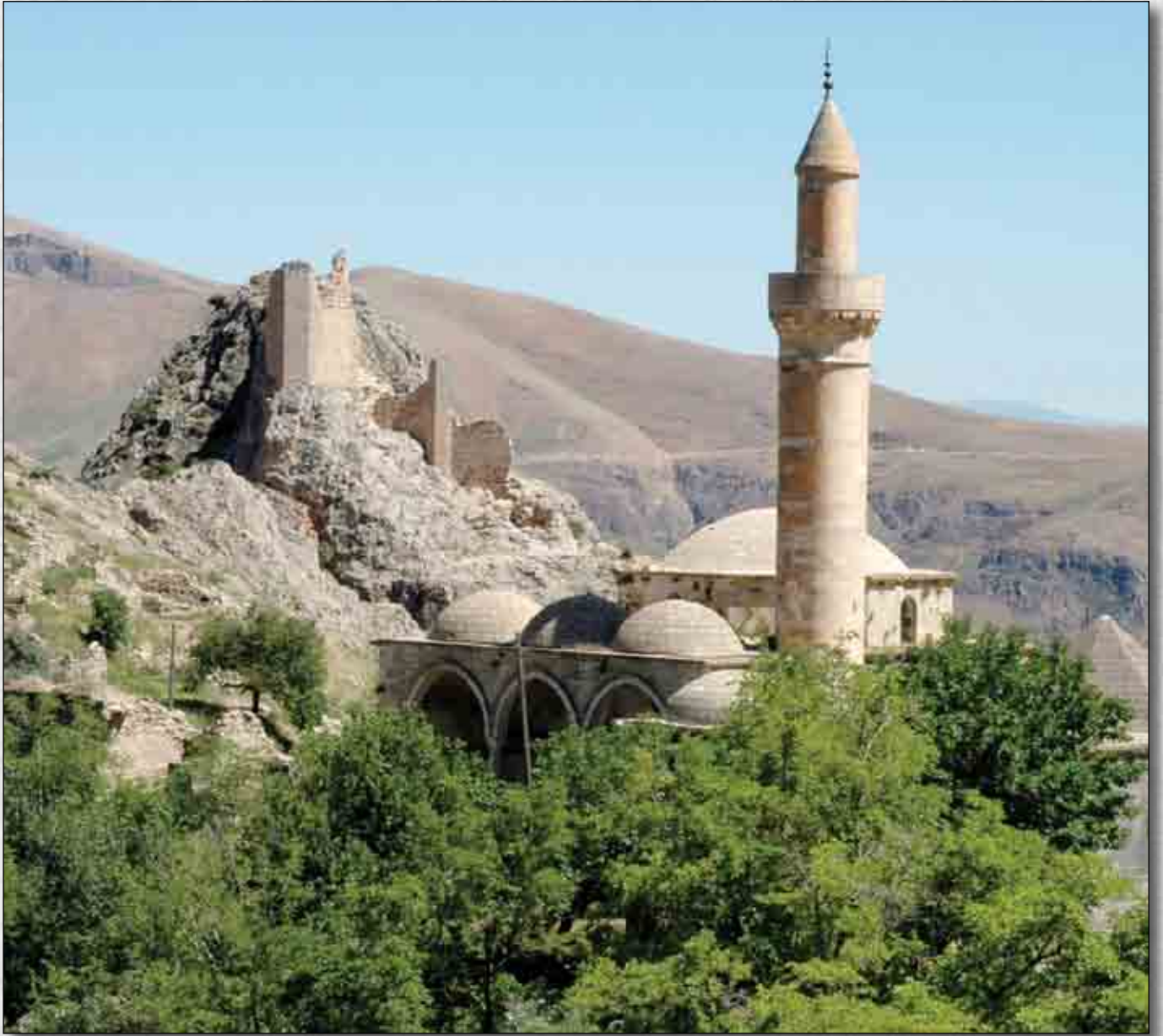
Pertek-Sağman Camii ve Kalesi
