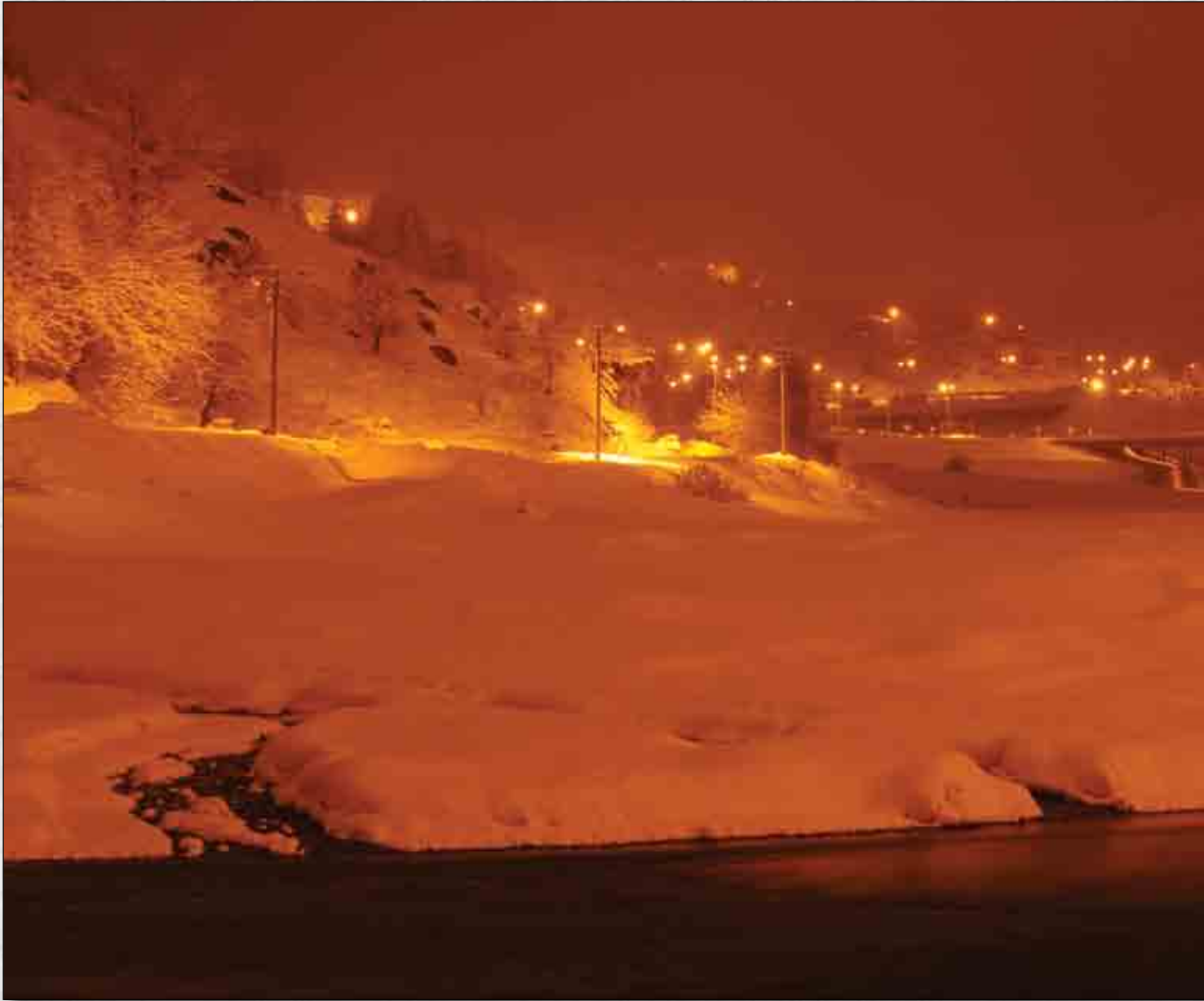
Tunceli Merkez Mameki Köprüsü
