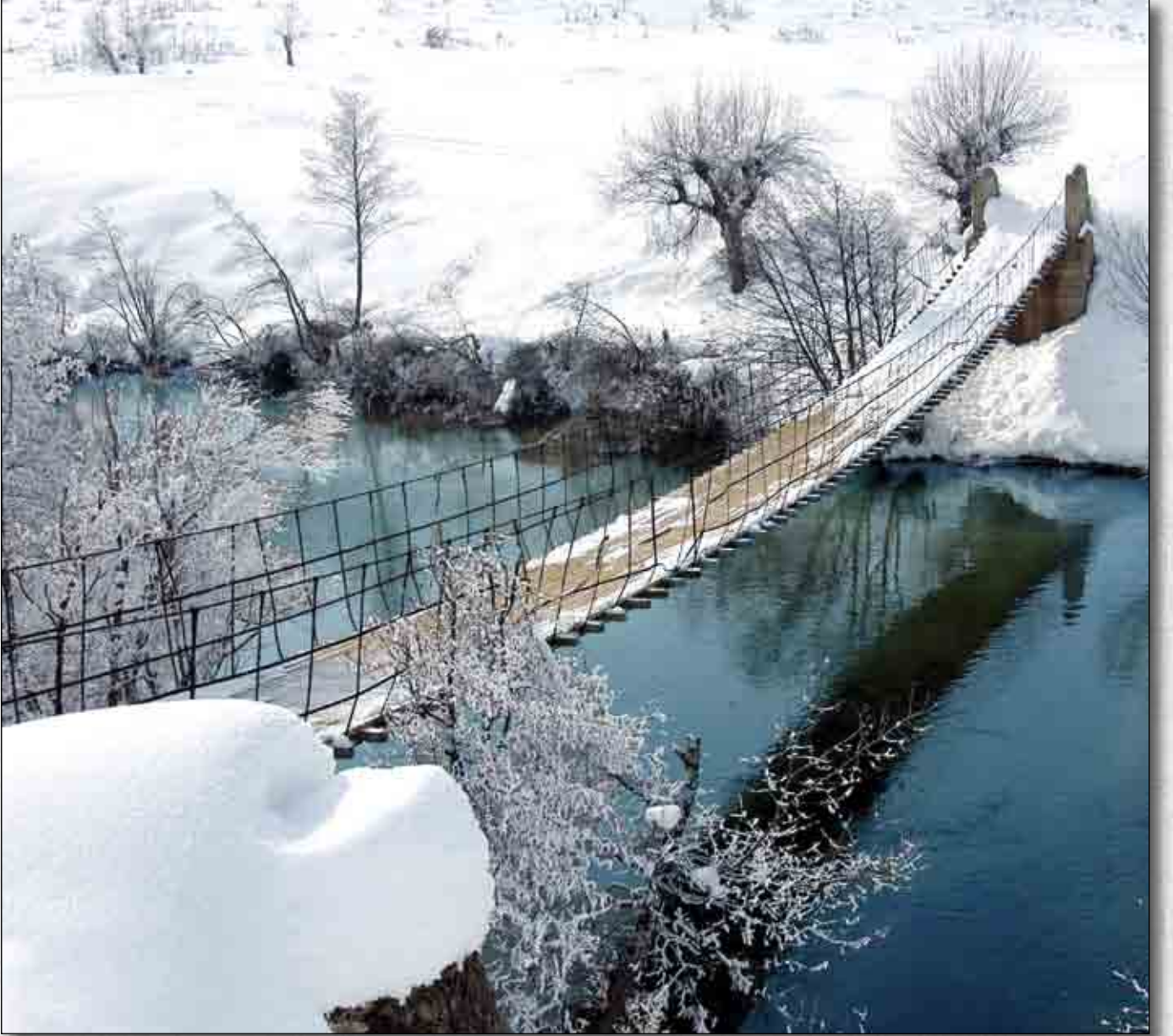
Munzur Suyu üzerinde asma köprü
