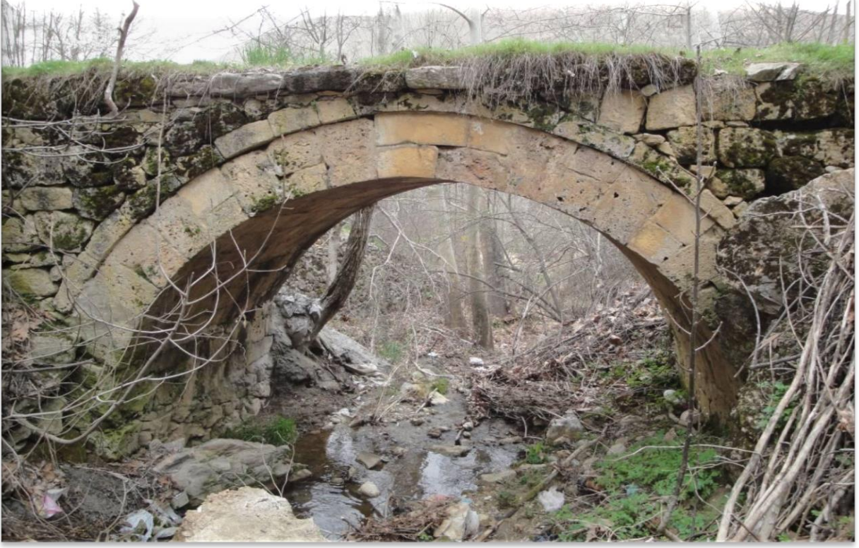
Resim 3. 16. Yusuf Kamil Paşa (Küçük Köprü) Köprüsü
