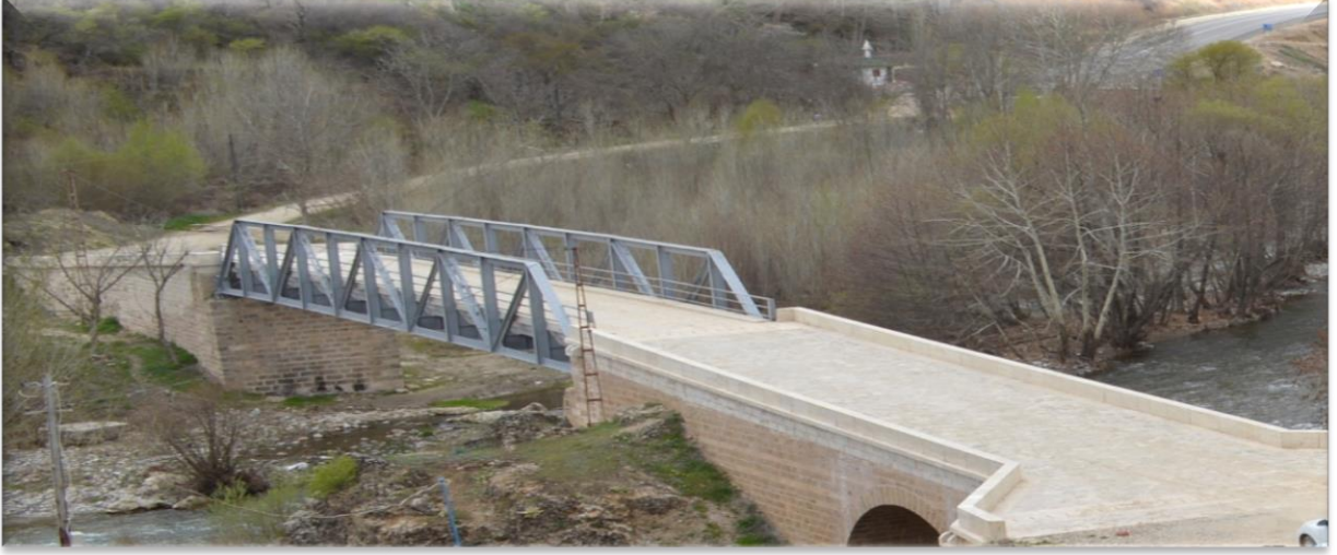
Resim 3. 12. Kozluk Çayı Köprüsü
