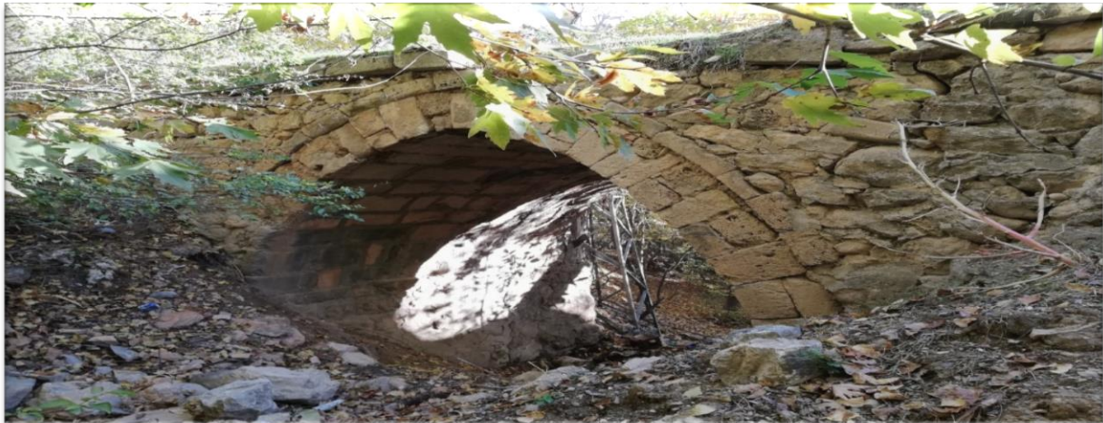
Resim 3. 15. Deveci Dere Köprüsü
