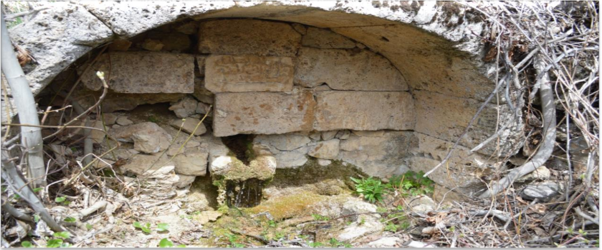
Resim 3.20. Ali Velikzade (Hamam) Çeşmesi
