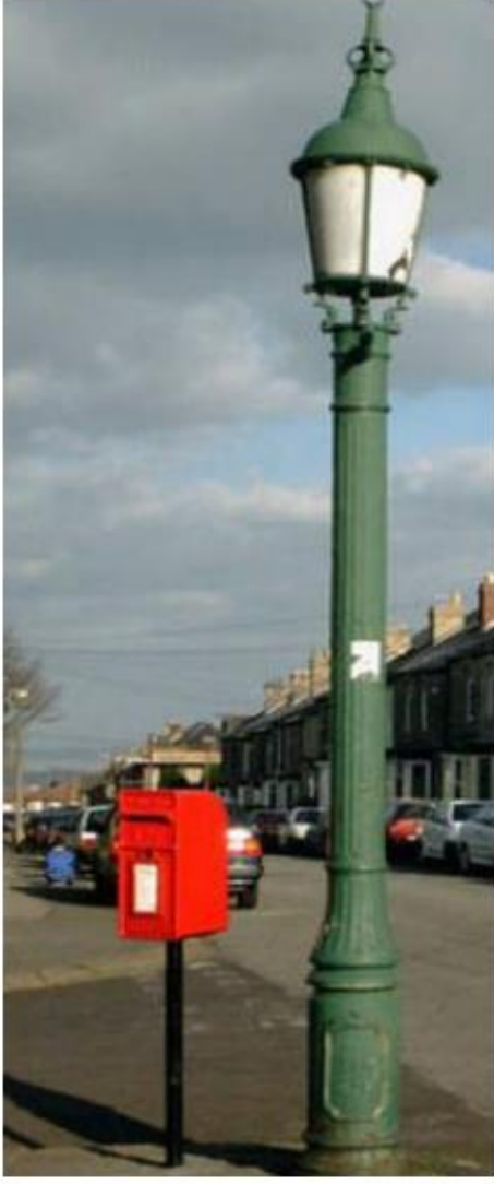
Şekil 5 Biyogaz tipi sokak lambası
