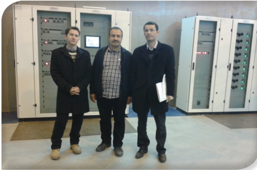
Özaltın Enerji Üretim ve İnşaat A.Ş. firmasına ait Yedisu Hes Barajı Santralı ziyareti
