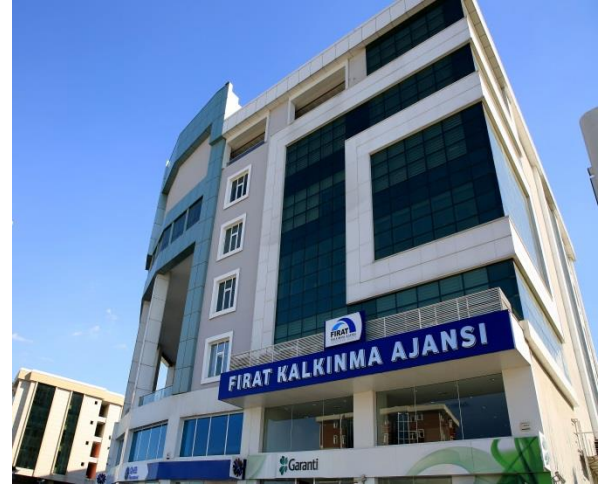
Resim 2: Ajans Hizmet Binası
