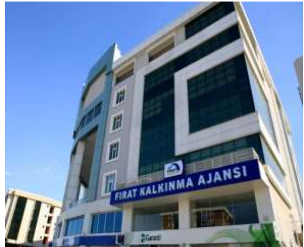
Resim 2: Ajans Hizmet Binası
